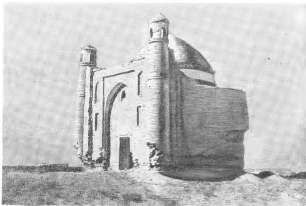
Рис. 14. Мавзолей Шокая в селе Байкадам. Общий вид с юго-восточной стороны. Середина XIX века.
